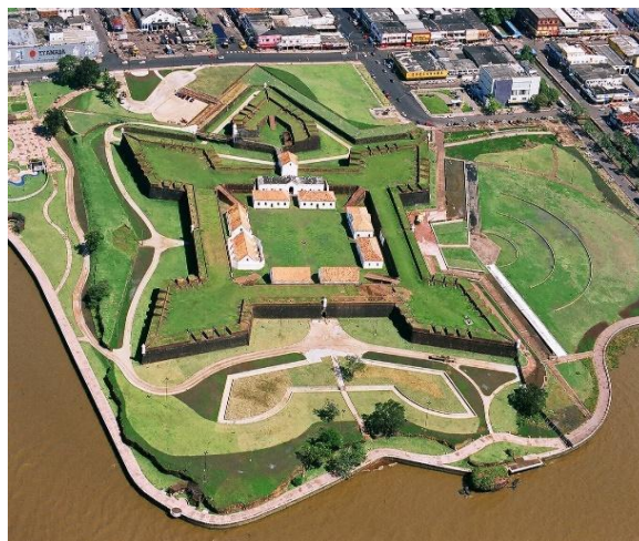
Figura 6: Vista aérea da Fortaleza de São José de Macapá -AP
